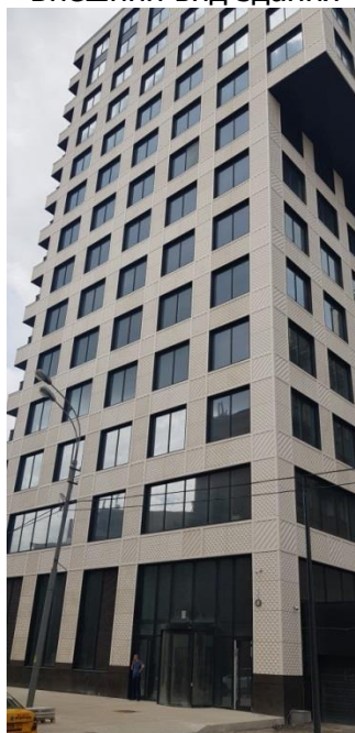
Внешний вид здания
