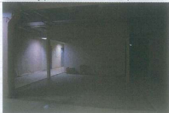
Внутреннее состояние помещений
