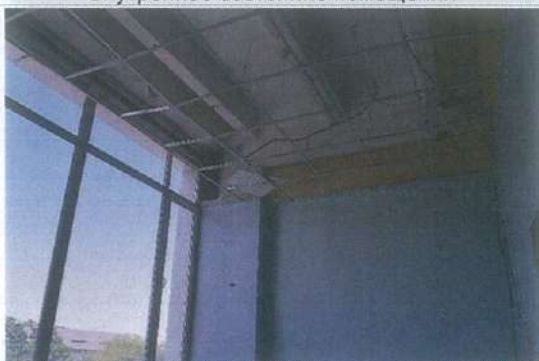
Внутреннее состояние помещений
