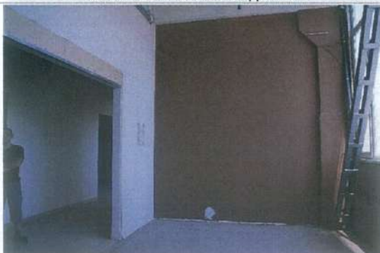
Внутреннее состояние помещений
