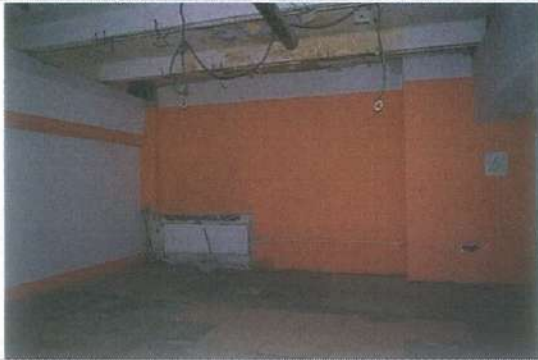
Внутреннее состояние помещений
