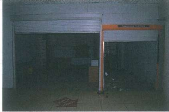
Внутреннее состояние помещений
