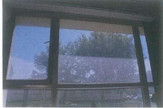
Внутреннее состояние помещений
