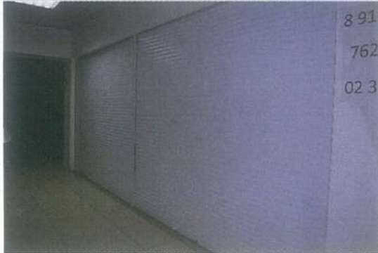
Внутреннее состояние помещений
