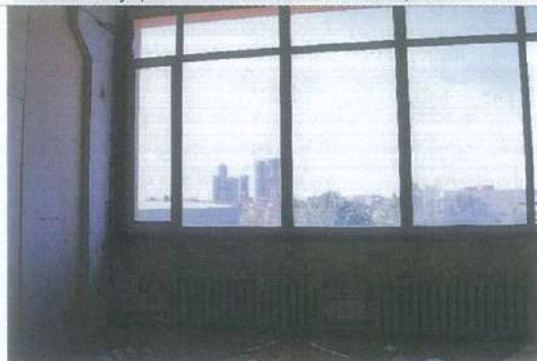
Внутреннее состояние помещений
