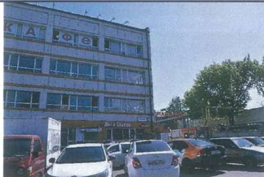
Внешнее состояние зданий
