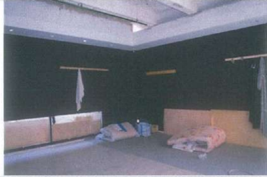
Внутреннее состояние помещений
