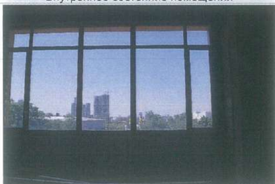
Внутреннее состояние помещений
