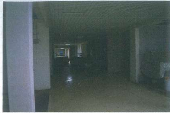
Внутреннее состояние помещений
