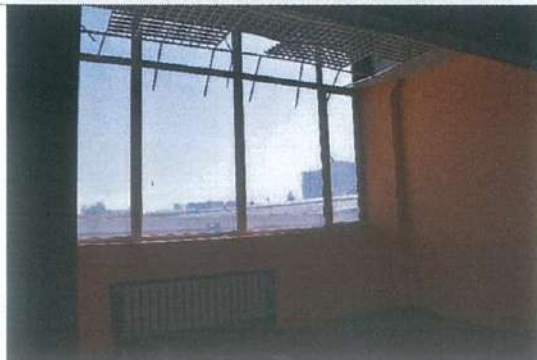
Внутреннее состояние помещений
