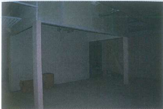
Внутреннее состояние помещений
