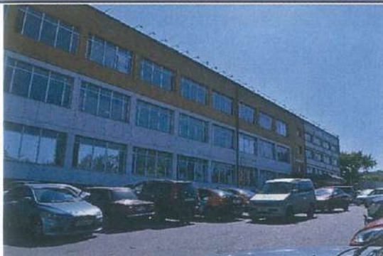
Внешнее состояние зданий
