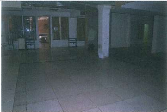
Внутреннее состояние помещений
