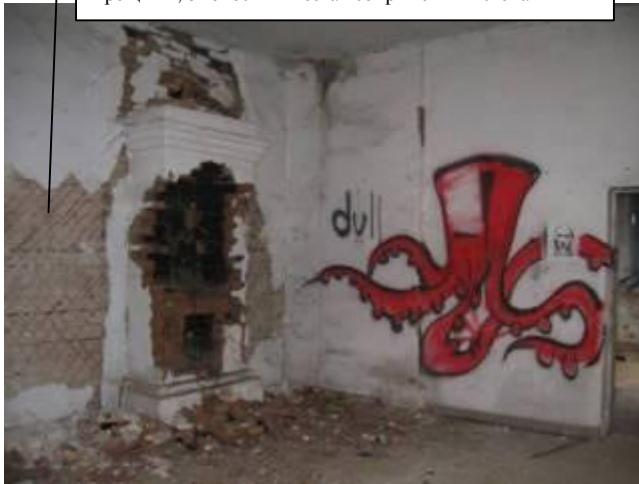
выпучивание и заметное отклонение от вертикали, трещины, зыбкость в местах сопряжения к стенам
