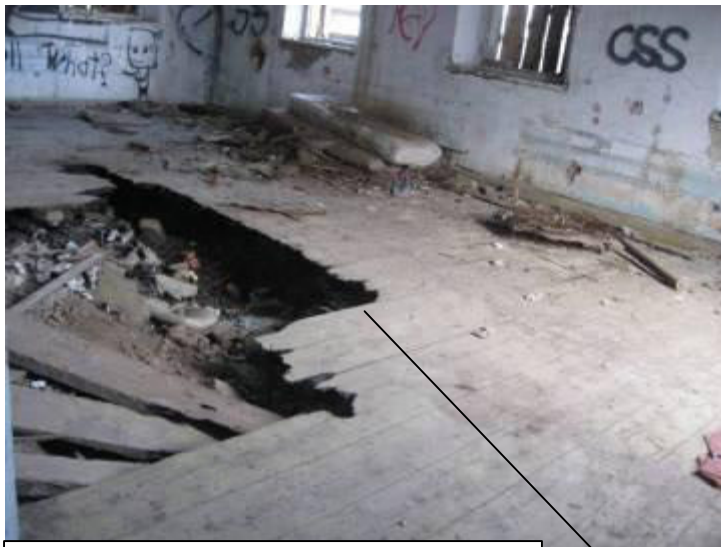
выпучивание и заметное отклонение от вертикали, трещины, зыбкость в местах сопряжения к стенам
