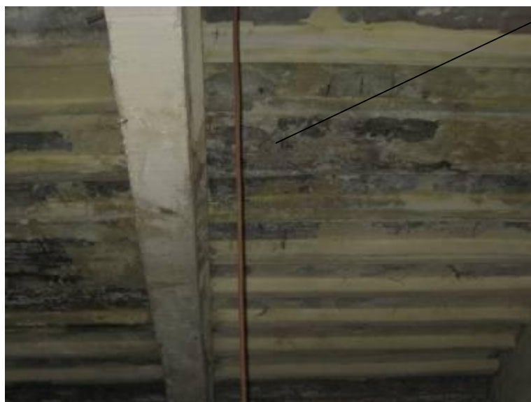
прогибы, трещины различных направлений, отпадение защитного слоя нижних плит с обнажением арматуры
