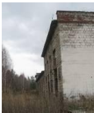
вертикальные трещины в простенках, расслоение кладки стен местами, нарушение связи отдельных участков кладки, местами разрушения
