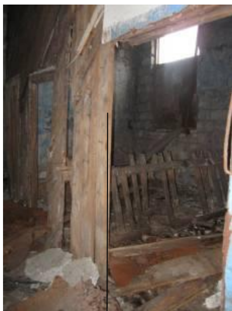
горизонтальные трещины на поверхности, заметное выпучивание, местами разрушение
