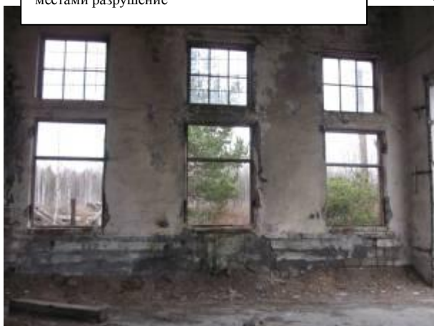
горизонтальные трещины на поверхности, заметное выпучивание, обнажение арматуры, местами разрушение
