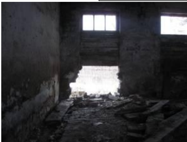
вертикальные трещины в простенках, расслоение кладки стен местами, нарушение связи отдельных участков кладки, местами разрушения
