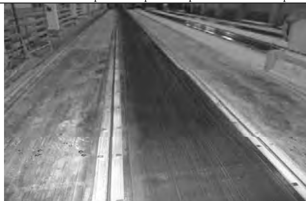
2.2 Металлопокрытие с фаскообразователями и фиксаторами.
