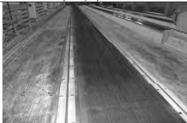
2.2 Металлопокрытие с фаскообразователями и фиксаторами.
