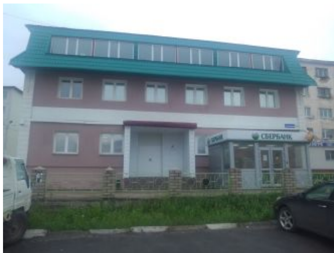
Общий вид объекта оценки и окружающей территории
