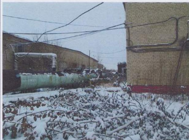
**Рис. 32: Тепловой магистральный трубопровод**
