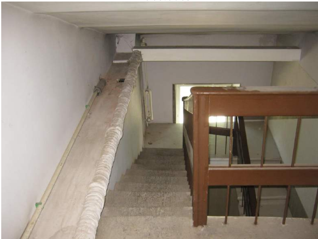
16. Лестничный пролет на чердак
