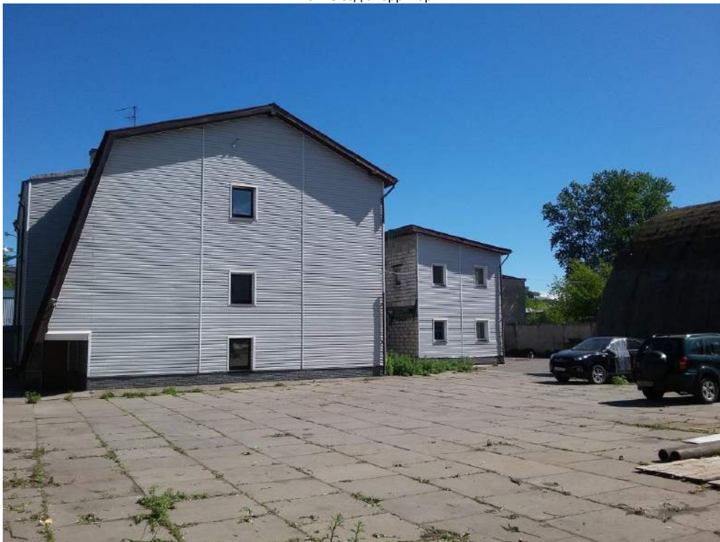
6. Незарегистрированные: пристройка к офисному зданию и отдельно стоящее здание охраны
