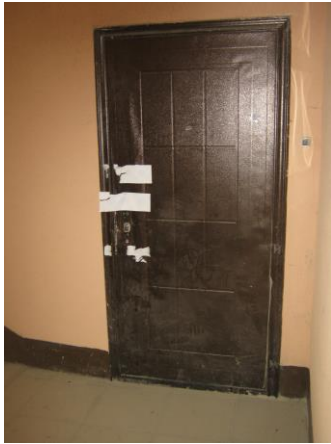
19. Входная дверь снаружи
