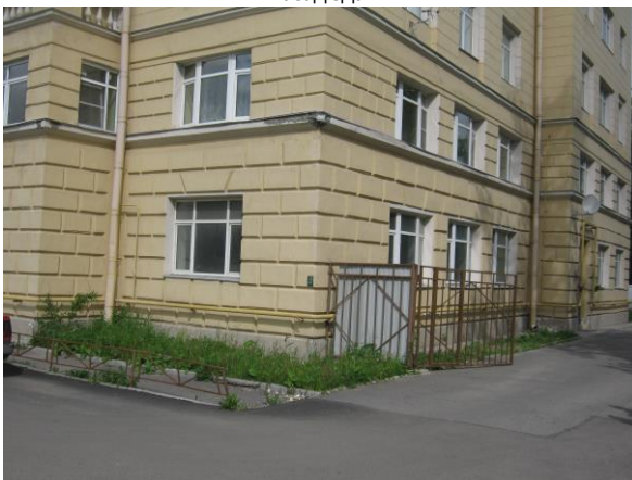
3. Окна помещения с торца здания
