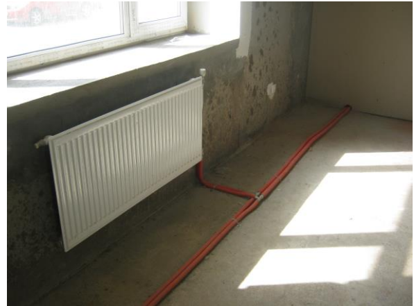
14. Типичные для всего помещения радиаторы отопления
