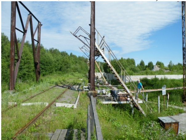
Фото 9 Эстакада под резервуарный парк (Эстакада с лестницей на ж/бетонных столбах)
