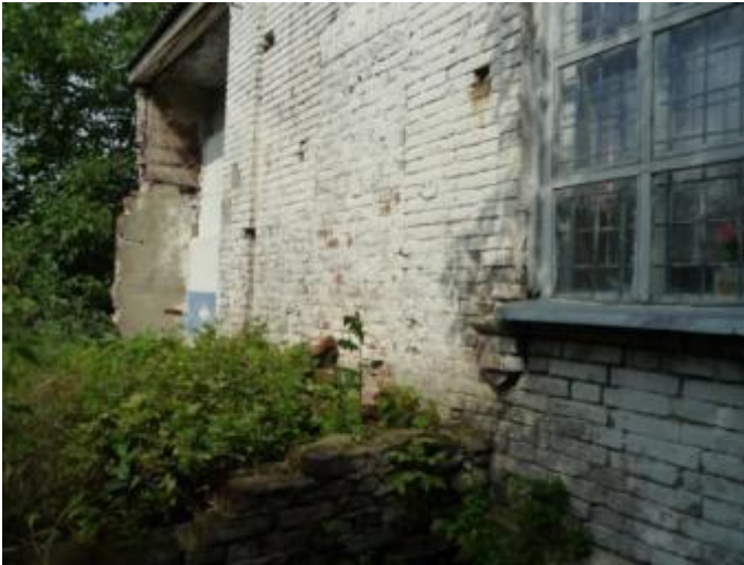
Следы разрушения, отсутствующей площади с тыльной стороны здания литер П-А, А, а1.
