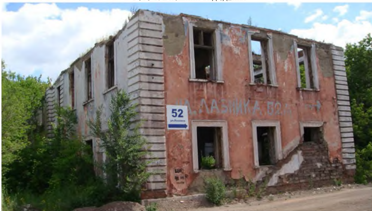
Фото 1. Внешний вид здания
