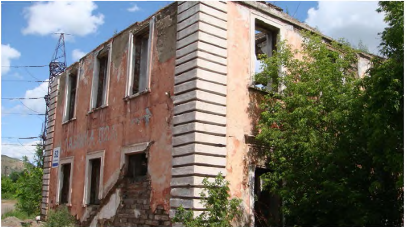
Фото 2. Внешний вид здания
