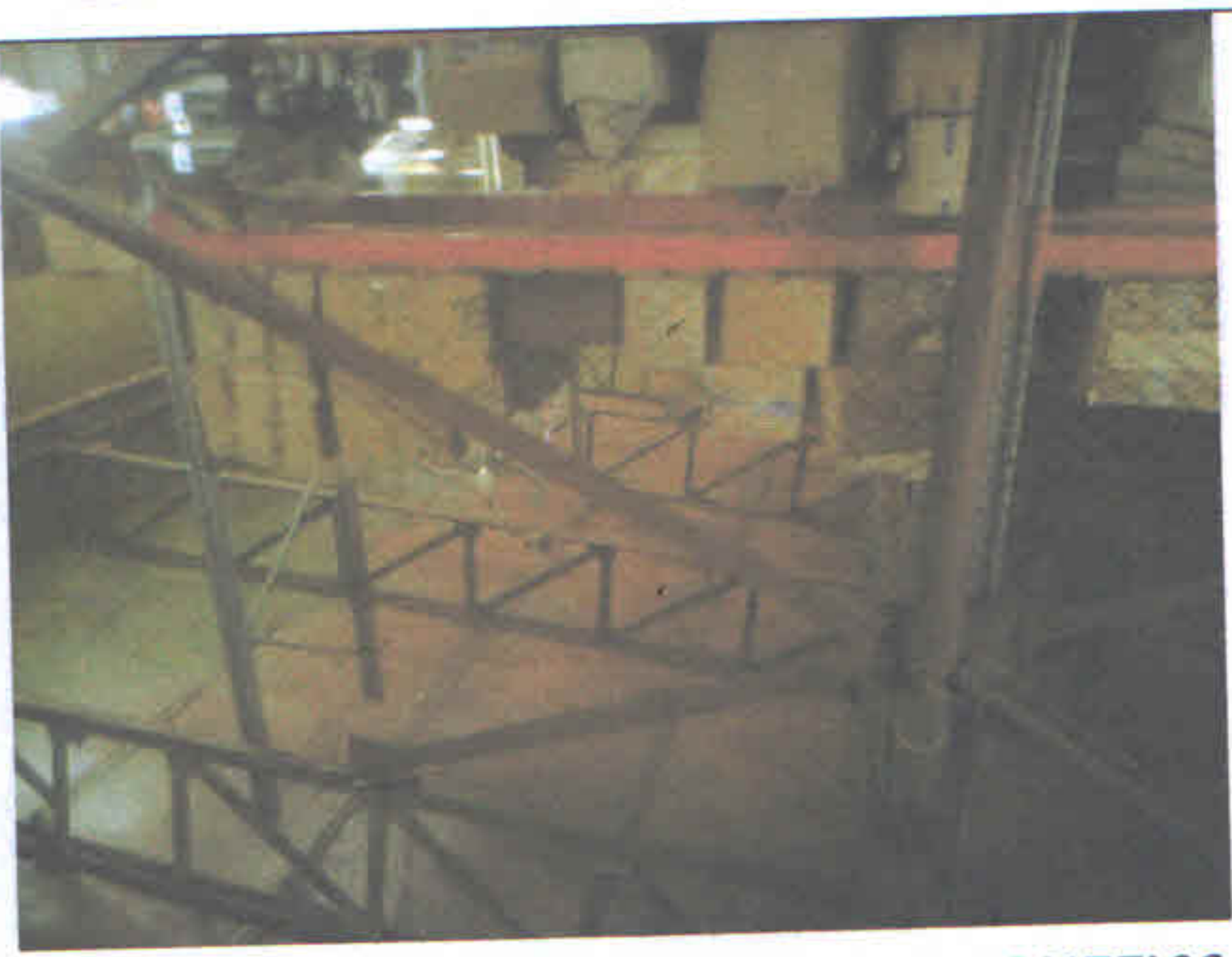
Фото 11, 12. Здание ремонтных мастерских, общ. пл. 333,7 кв.м (назначение – нежилое, инв.№ 1718, литер – Г, этажность – 1, усл. ном. 35:22:0112036:0314:1718:0000)
