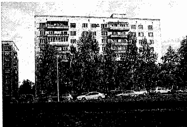
Общий вид жилого дома
