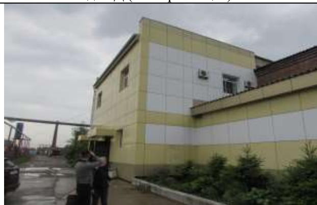
Фотография 9 – Общий вид объекта оценки – Нежилые помещения II (15-34), I (26) расположенные на 2-ом этаже здания по адресу: Хабаровский край, г.Хабаровск, ул.Целинная, д.10Д
