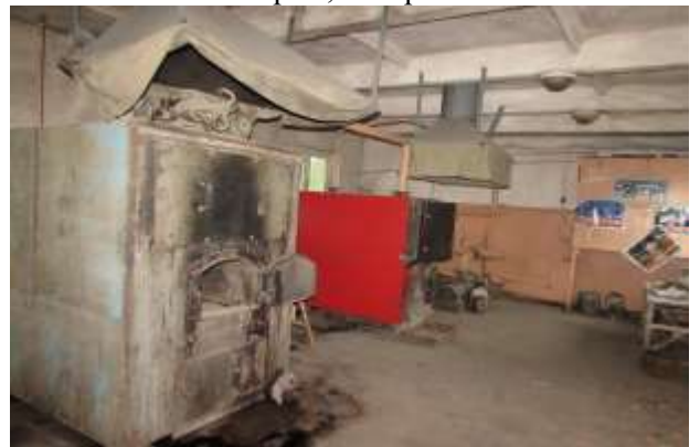
Фотография 4 – Общий вид объекта оценки – гараж, литер Б
