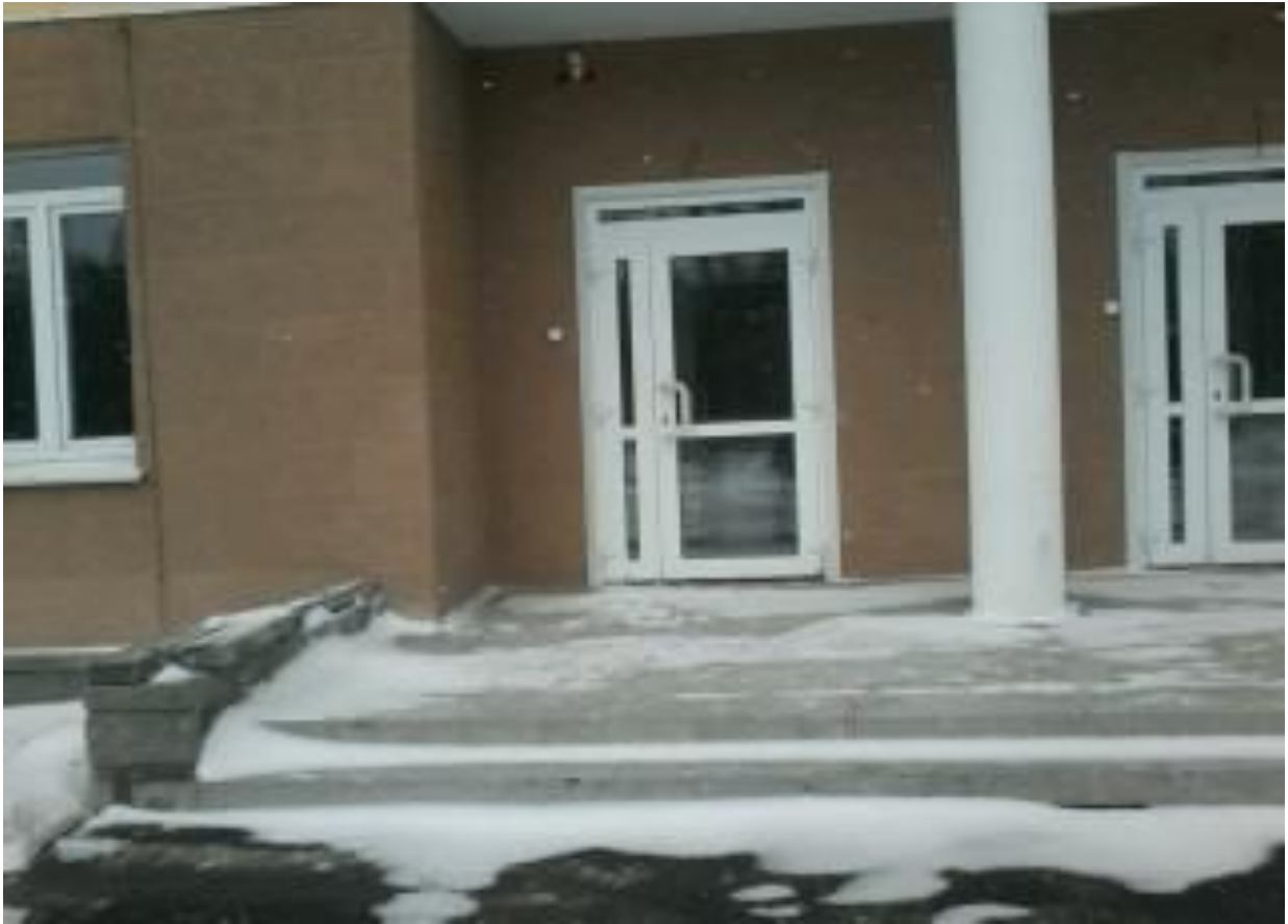
Фото. 2. Вход в помещение
