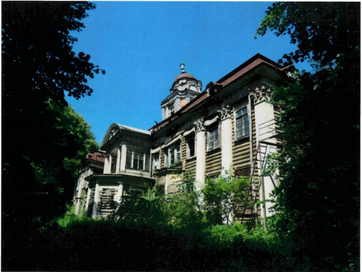
Фото №3. Северный фасад. Общий вид.
