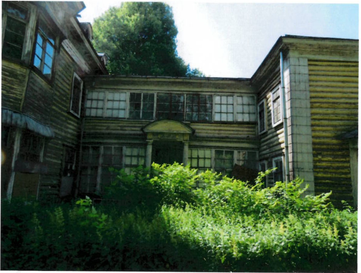
Фото №7. Фрагмент южного фасада.
