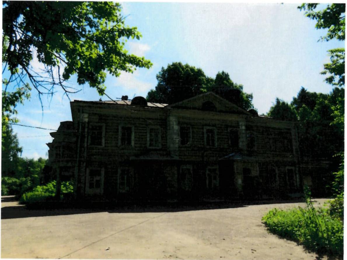
Фото №6. Восточный фасад. Общий вид.
