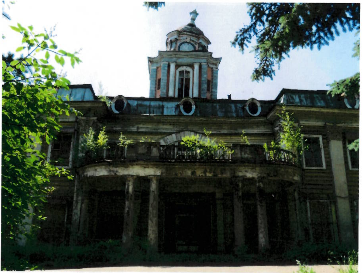
Фото № 1. Фрагмент южного фасада.
