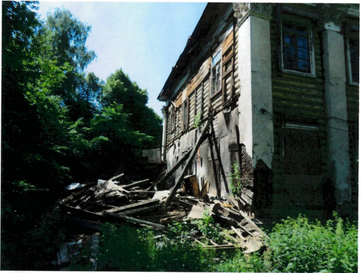
Фото №5. Западный фасад. Общий вид.
