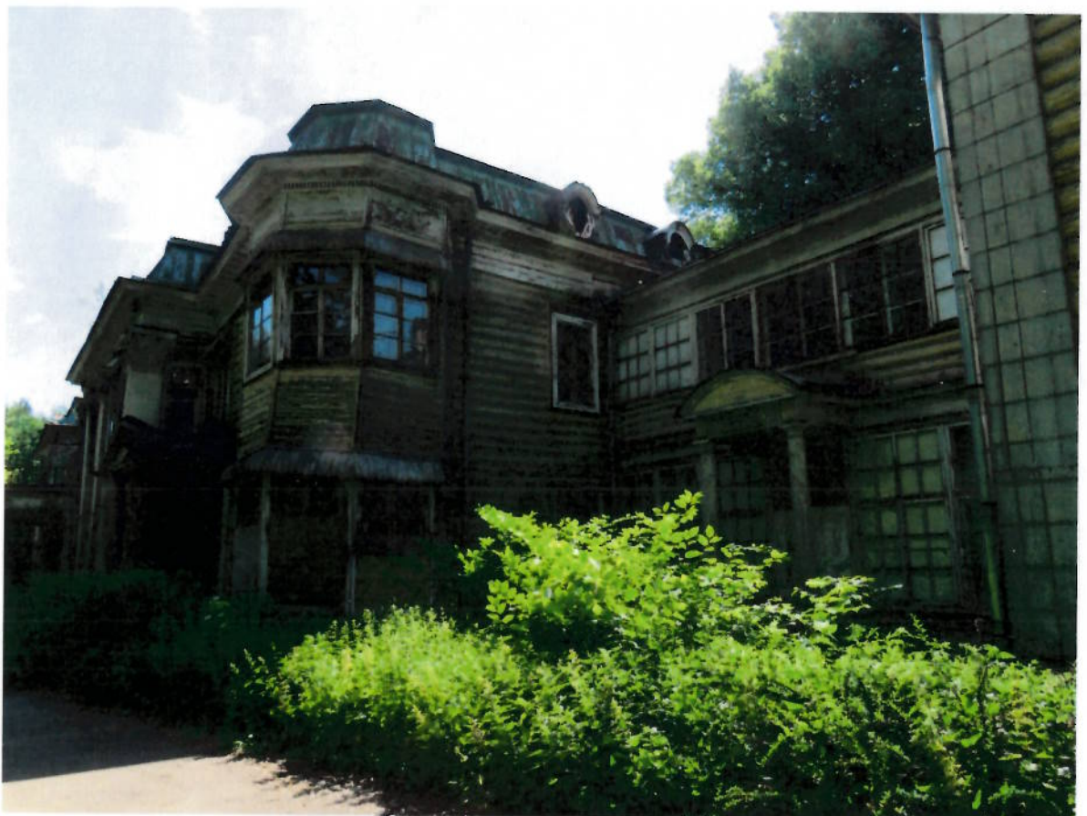
Фото №8. Фрагмент южного фасада.
