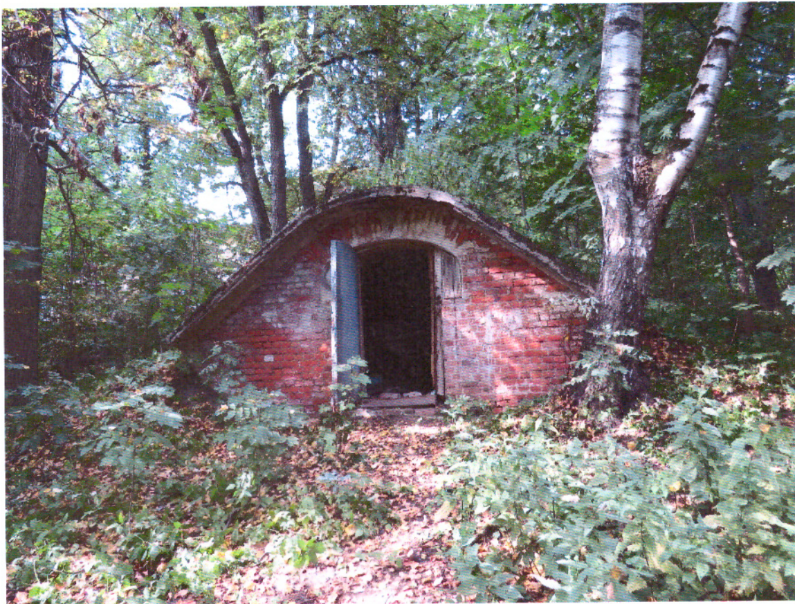
Фото № 1 Западный фасад.
