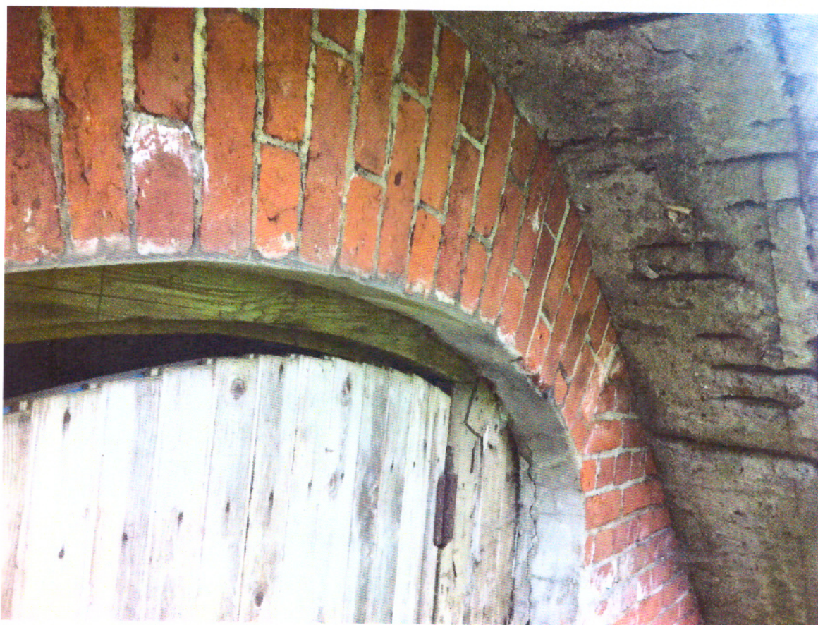
Фото № 4 Фрагмент западного фасада.
