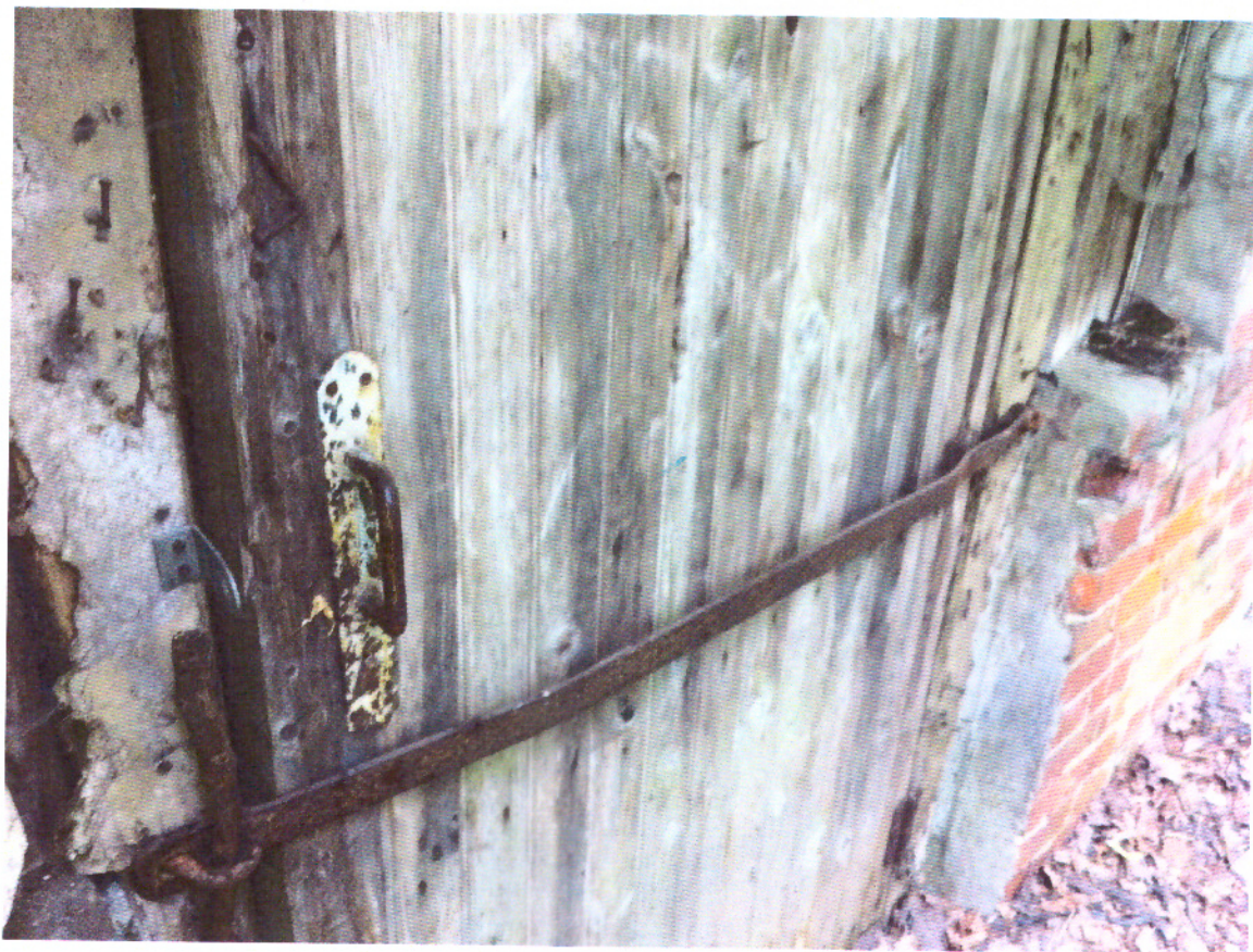
Фото № 5 Фрагмент восточного фасада. Деревянная дверь с запорным устройством.
