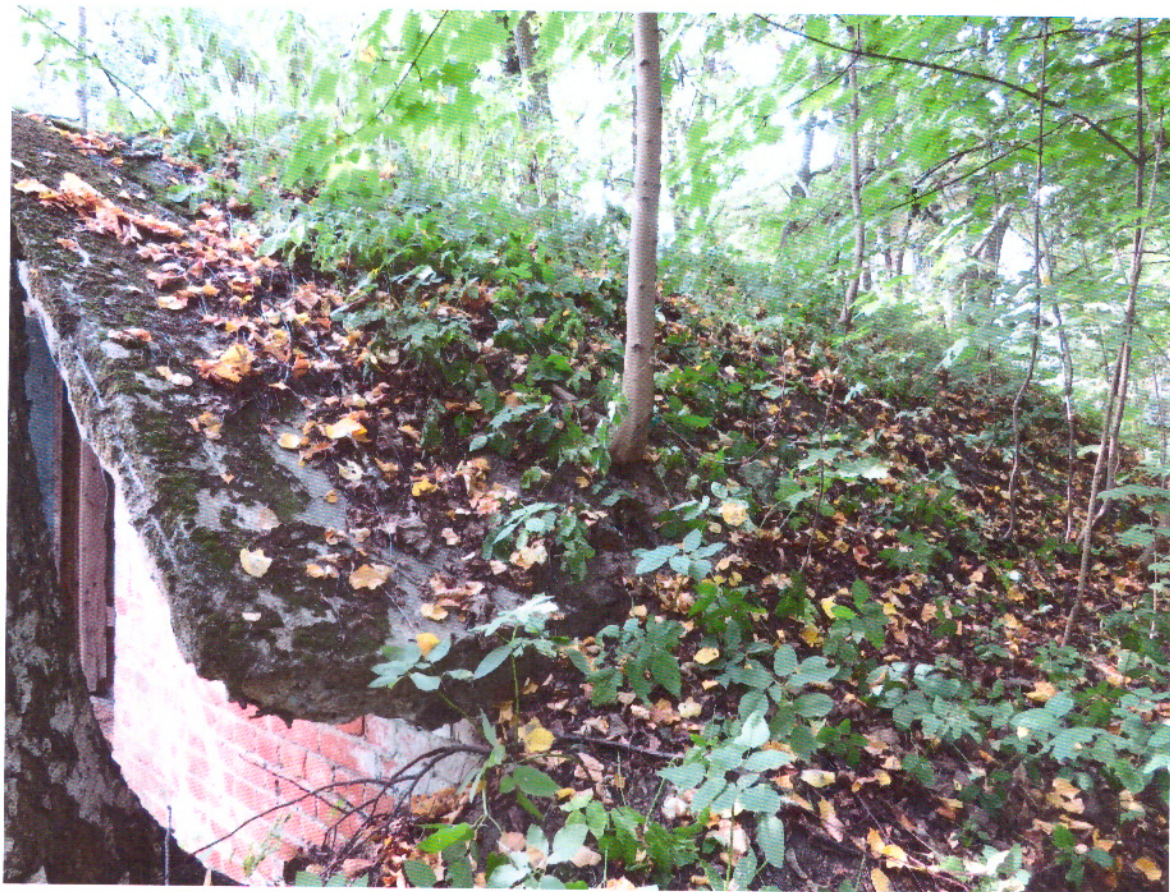
Фото № 3 Вид на кровлю с севера.
