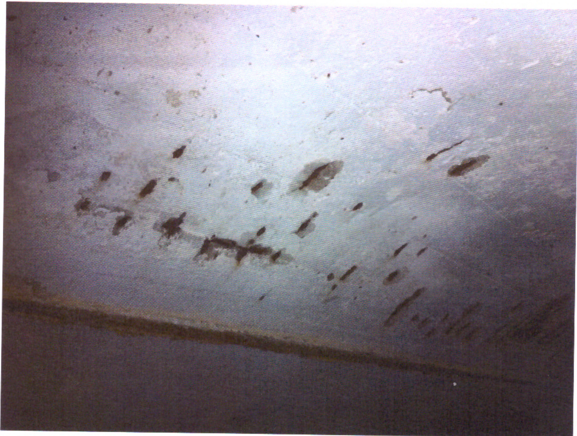
Фото № 8 Фрагмент бетонного свода.
