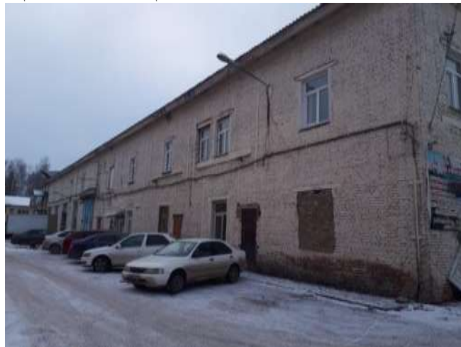
Фото №2 Фасад здания
