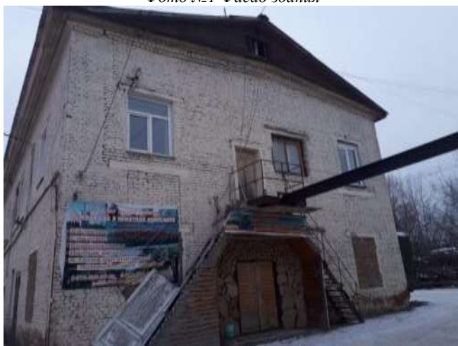
Фото №3 Фасад здания
