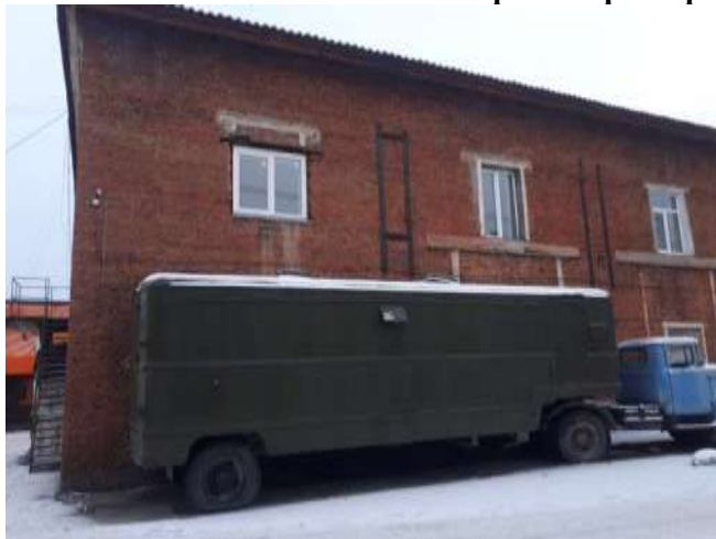
Фото №1 Фасад здания
