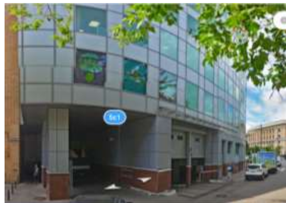
Фасад здания, въезд в паркинг
