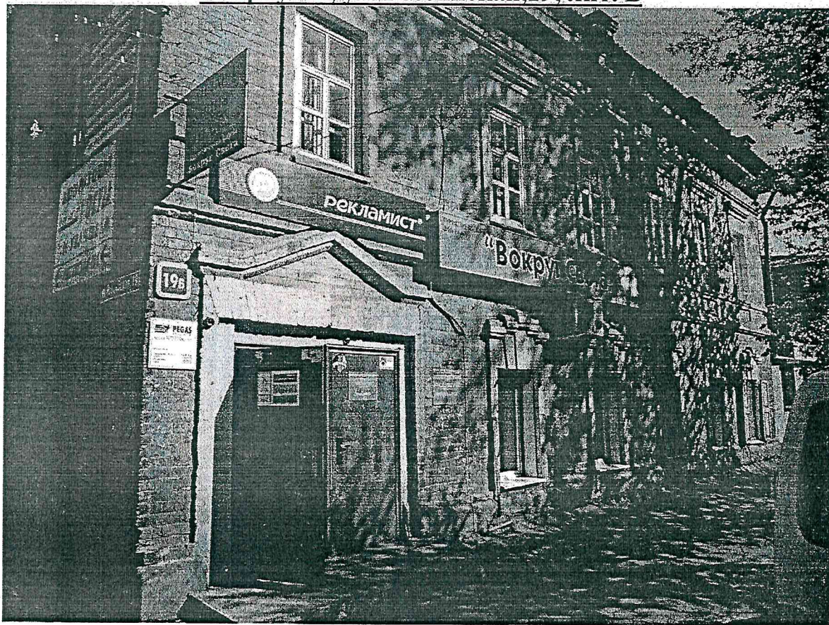
Главный фасад со стороны ул. Российская
