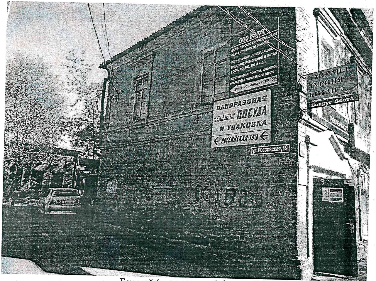
Боковой (юго-западный) фасад
