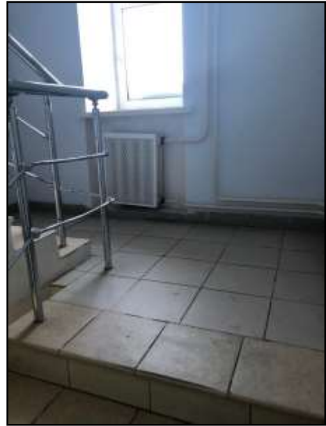
Фото № 14 Лестничная клетка
