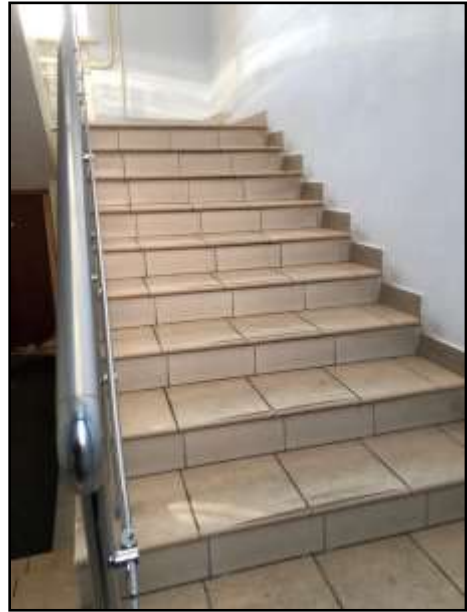
Фото № 10 Лестничная клетка
