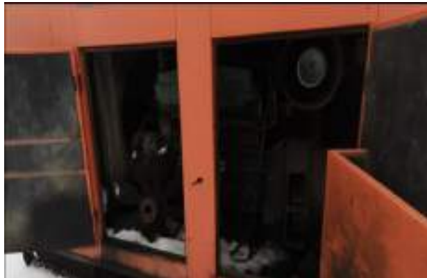
Общий вид объекта оценки - Дизельэлектростанция « АД200 Квт 400 Вт с дв. ЯМЗ».
