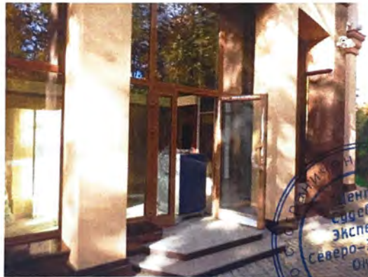
Отдельный вход с придомовой территории
