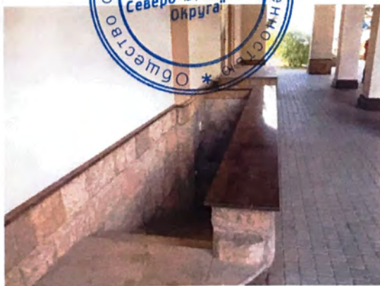
Вход в подвал
