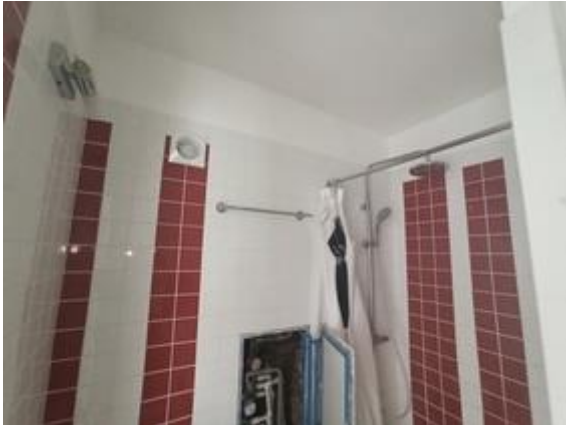
Рис. 2.2-17. Помещение Объекта оценки
