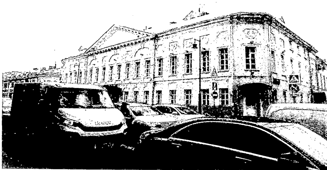
Фото 1. Главный фасад. Вид с востока. Стены оштукатурены и окрашены.
