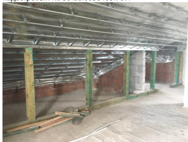
Фото 7.18. Внутренние помещения жилого дома кадастровый № 50:11:0050403:767.
