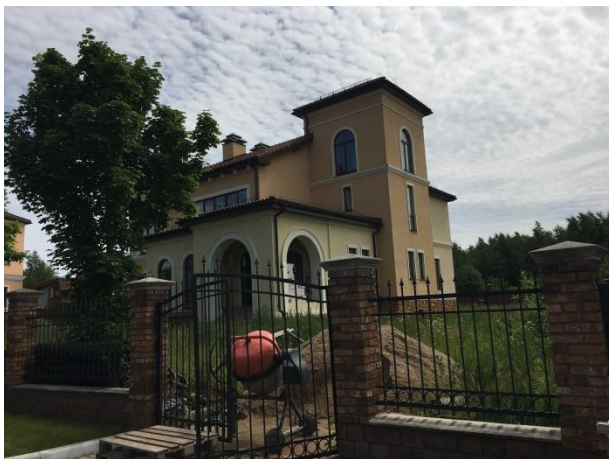
Фото 7.7. Внешний вид жилого дома кадастровый № 50:11:0050403:767.
