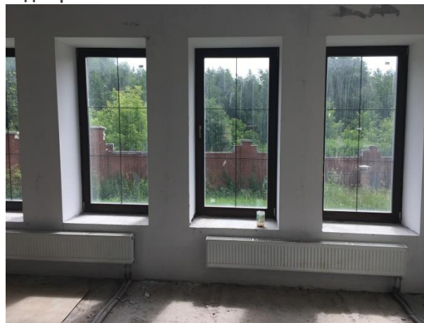
Фото 7.16. Внутренние помещения жилого дома кадастровый № 50:11:0050403:767.
