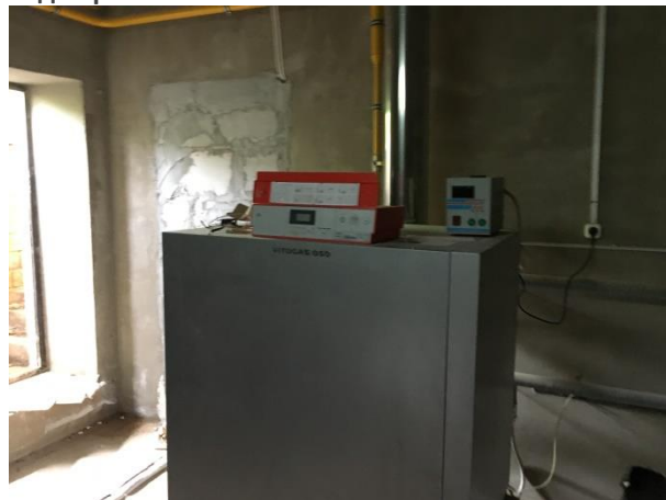
Фото 7.12. Внутренние помещения жилого дома кадастровый № 50:11:0050403:767.
