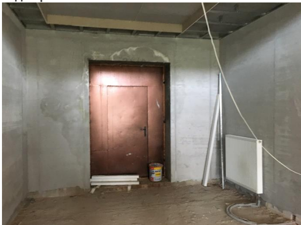
Фото 7.11. Внутренние помещения жилого дома кадастровый № 50:11:0050403:767.
