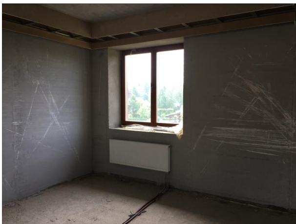
Фото 7.3. Внутренние помещения жилого дома кадастровый № 50:11:0050403:743.
