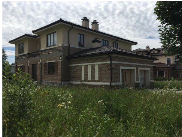
Фото 7.2. Внешний вид жилого дома кадастровый № 50:11:0050403:743.
