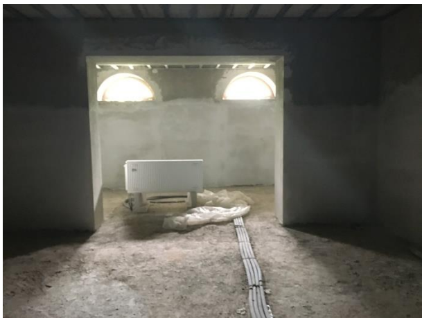
Фото 7.13. Внутренние помещения жилого дома кадастровый № 50:11:0050403:767.
