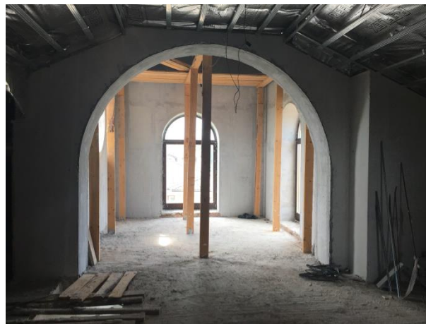
Фото 7.14. Внутренние помещения жилого дома кадастровый № 50:11:0050403:767.
