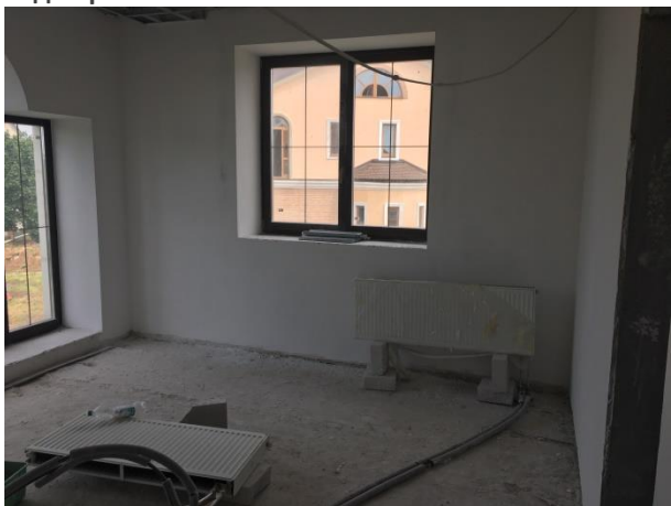
Фото 7.15. Внутренние помещения жилого дома кадастровый № 50:11:0050403:767.
