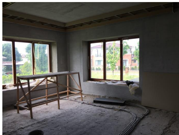
Фото 7.10. Внутренние помещения жилого дома кадастровый № 50:11:0050403:767.
