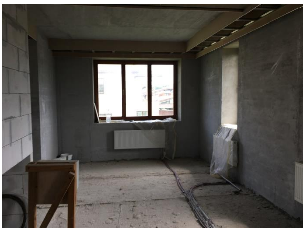
Фото 7.5. Внутренние помещения жилого дома кадастровый № 50:11:0050403:743.
