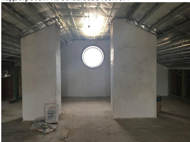
Фото 7.17. Внутренние помещения жилого дома кадастровый № 50:11:0050403:767.
