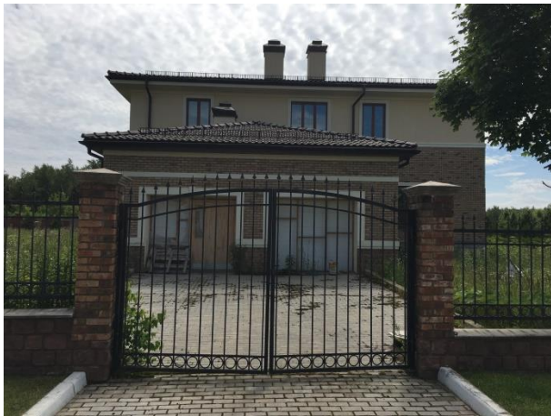
Фото 7.1. Внешний вид жилого дома кадастровый № 50:11:0050403:743.
