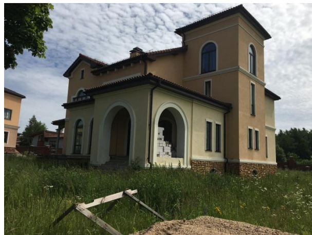
Фото 7.8. Внешний вид жилого дома кадастровый № 50:11:0050403:767.
