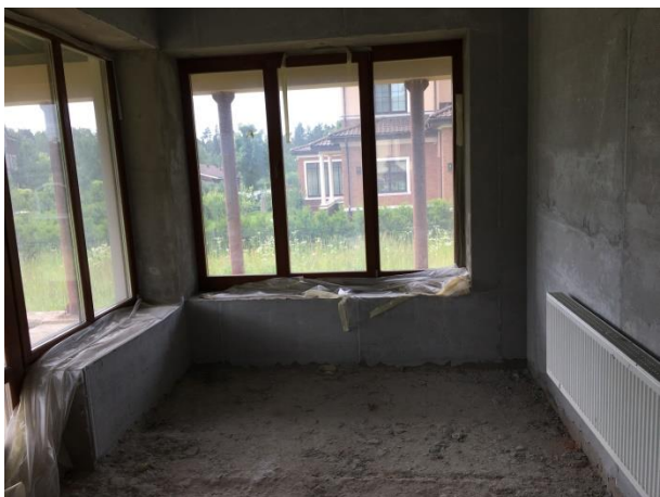
Фото 7.9. Внутренние помещения жилого дома кадастровый № 50:11:0050403:767.
