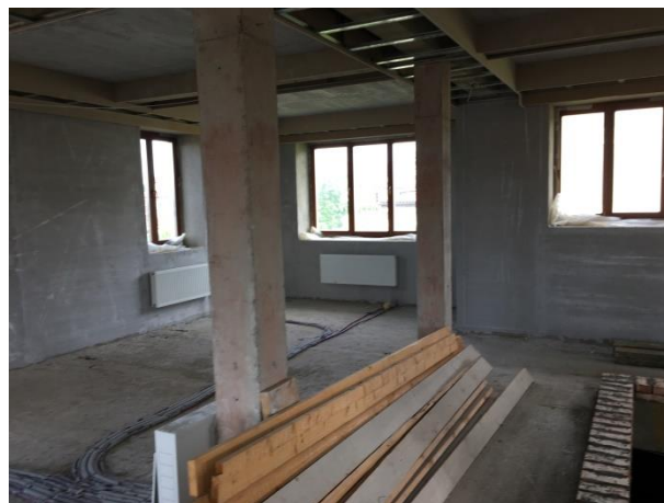
Фото 7.4. Внутренние помещения жилого дома кадастровый № 50:11:0050403:743.
