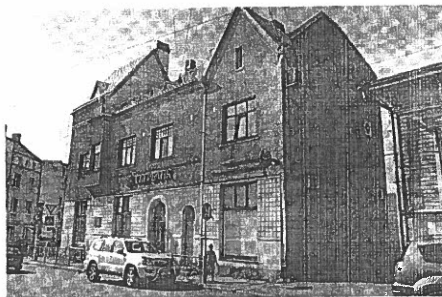
«Здание с конторой банка (кирпичное)» Республика Карелия, г. Сортавала, ул. Карельская, д. 13/ ул. Гагарина, д. 1 Общий вид со стороны ул. Гагарина Дата: июль 2016 года
