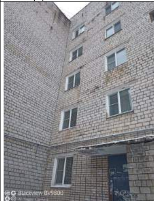
Фотография 3 – Общий вид жилого дома
