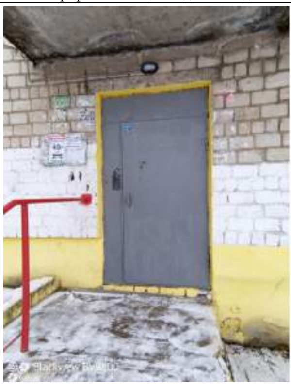
Фотография 4 – Общий вид жилого дома
