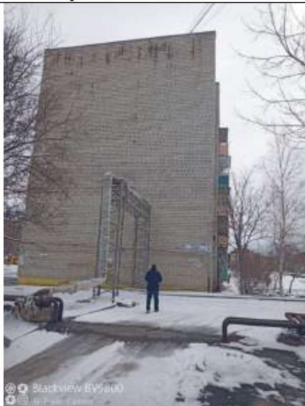
Фотография 2 – Общий вид жилого дома
