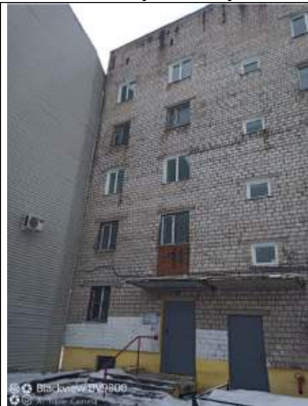
Фотография 1 – Общий вид жилого дома
