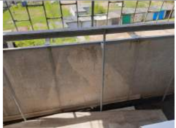
Фотография 14 – Вид жилого помещения
