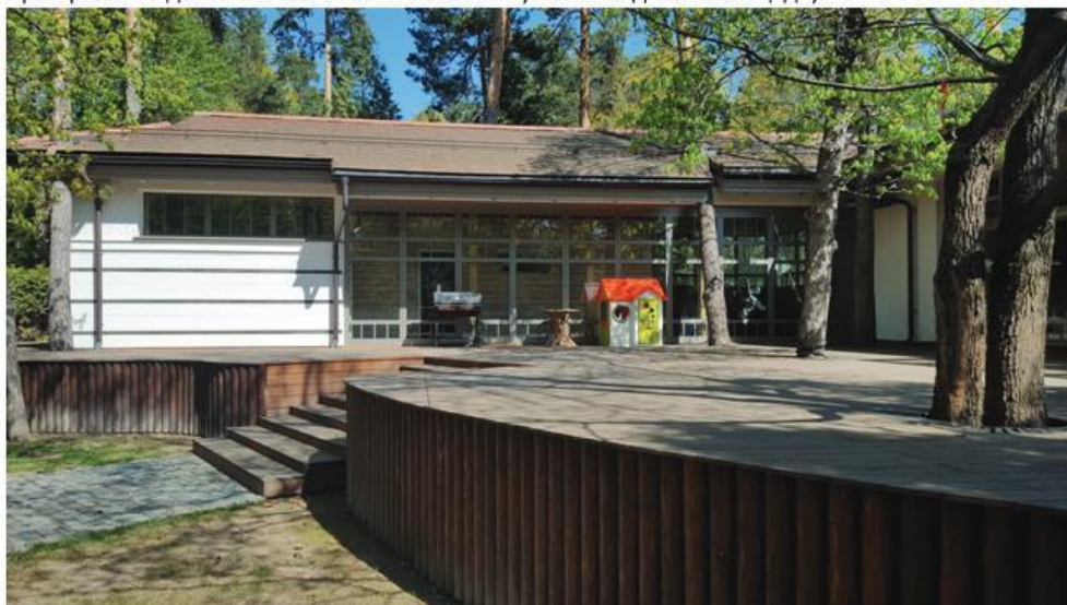
Пристройка к зданию с комплексом Хамам и Сауна с выходом на площадку
