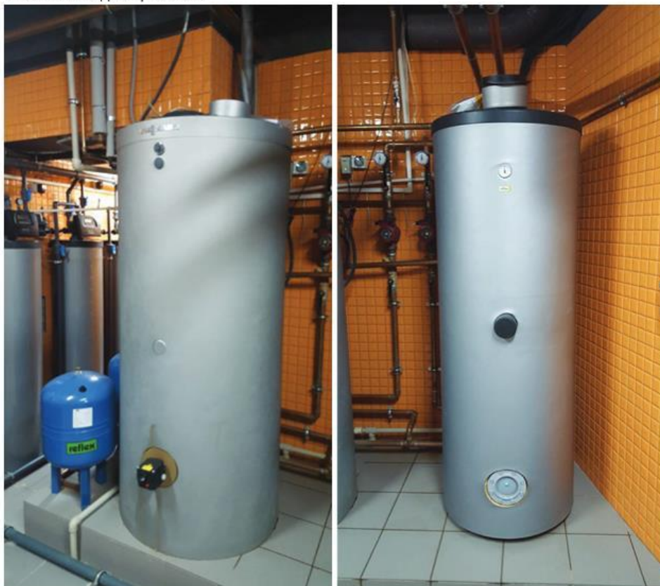
Емкостный водонагреватель
