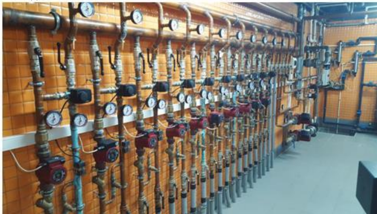
Разводка системы отопления
