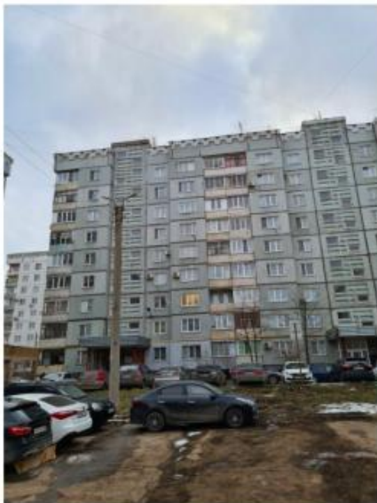
Фото №1. Фасад здания.
