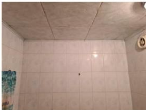
Фото №21. Ванная комната. Вид 1.
