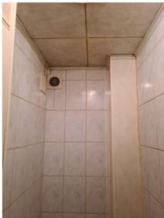
Фото №19. Санузел. Вид 1.
