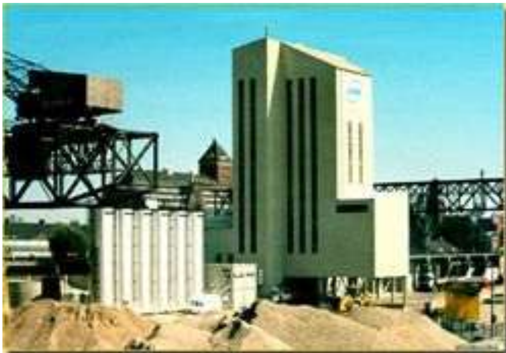
Полумобильный вариант асфальтосмесительной установки 100 SM производства TELTOMAT.
