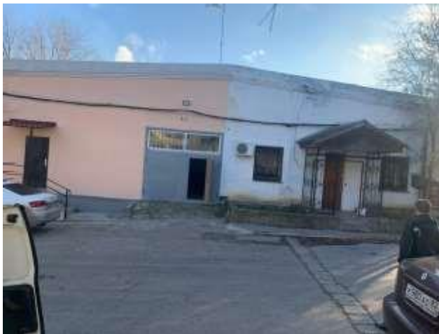
Фото 1 Нежилое помещение с кадастровым номером: 90:24:010110:1066, площадью 1 198,2 кв. м и земельный участок с 90:24:010110:3773, площадью 811 кв. м
