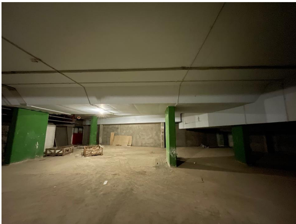
Фото 9 Внутреннее состояние объекта оценки
