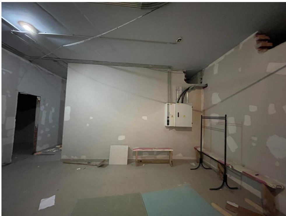
Фото 10. Внутреннее состояние объекта оценки
