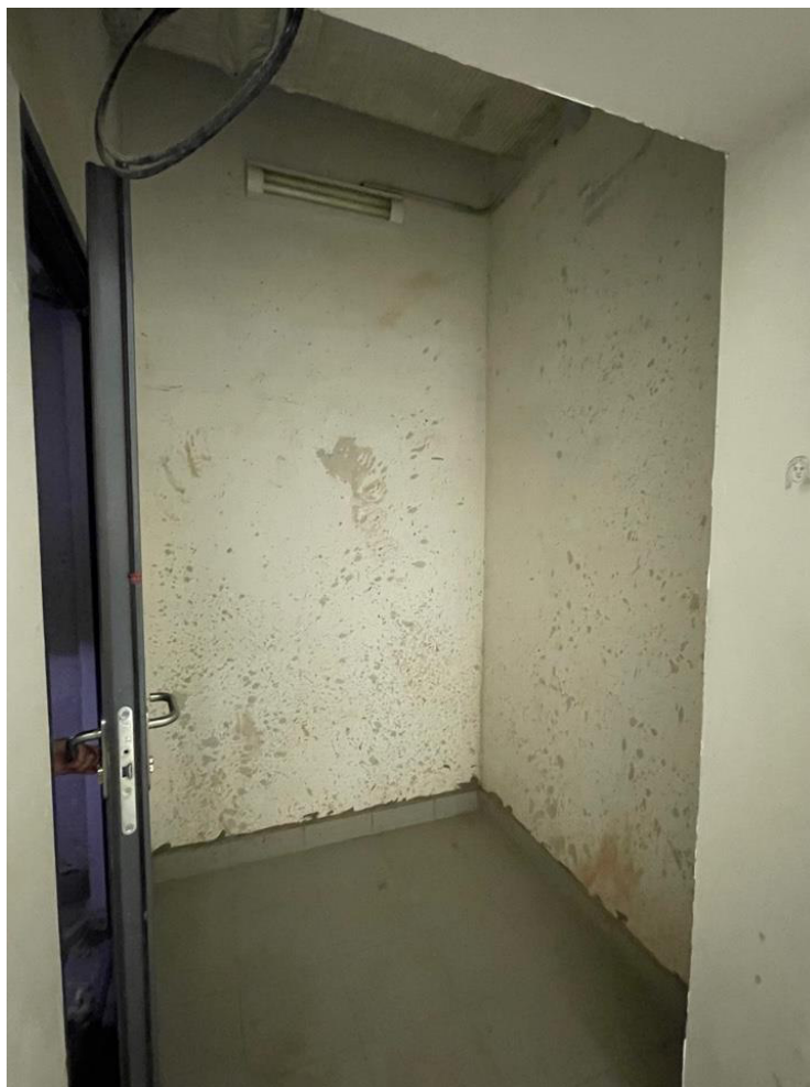
Фото 13. Внутреннее состояние объекта оценки
