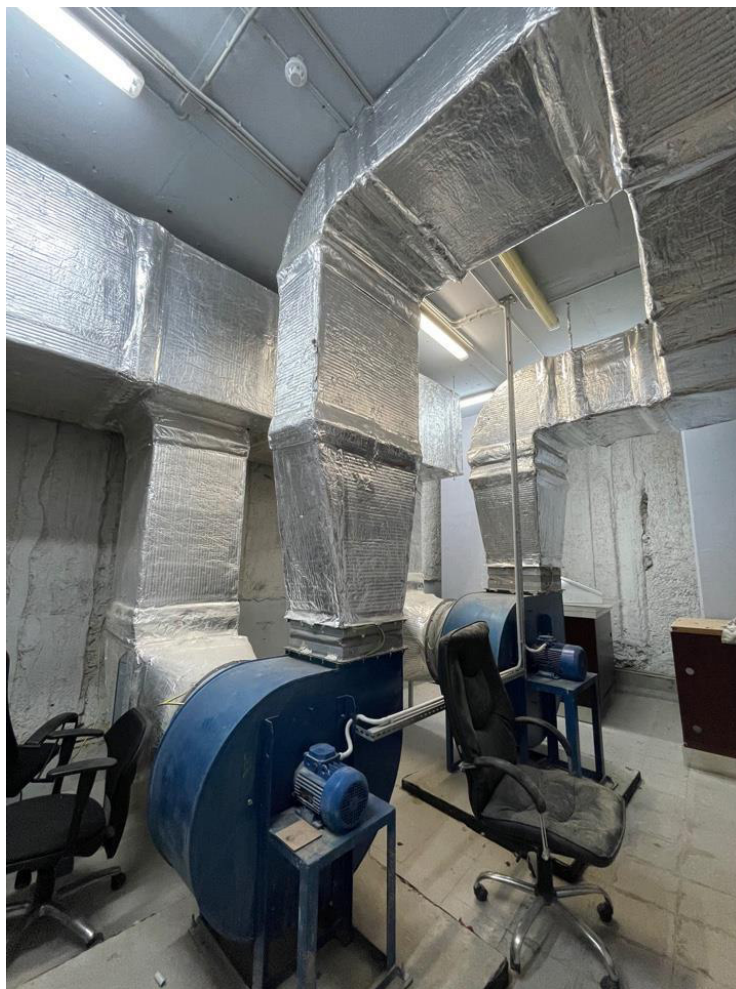
Фото 14. Внутреннее состояние объекта оценки
