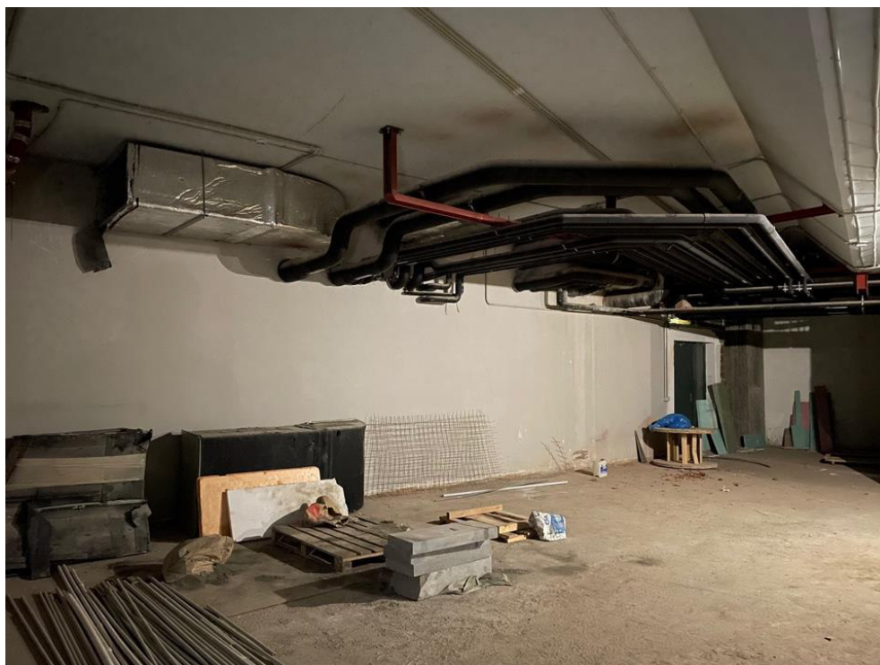
Фото 8. Внутреннее состояние объекта оценки
