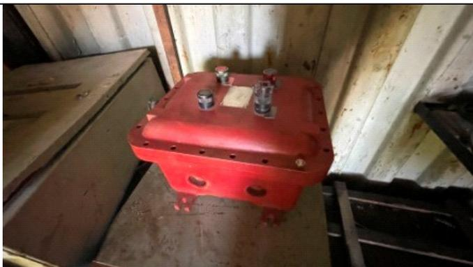
**Фото 13. Частотный преобразователь**
