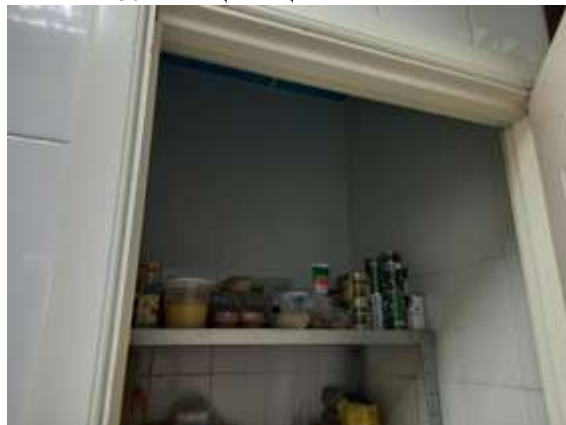
52. Помещения цокольного этажа
