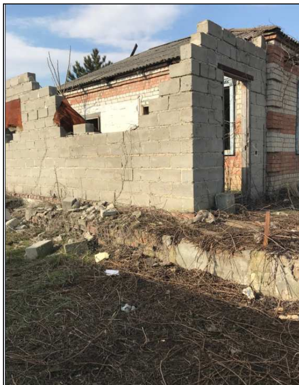
Объект незавершенного строительства
