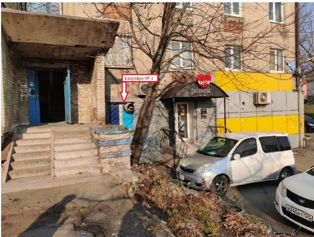
Рис. 1 – Фасад квартир № 1 и № 2. Затемненный оконный проем квартиры № 1. В квартиру № 2 организована входная группа. Заложенные оконные проемы квартиры № 3
