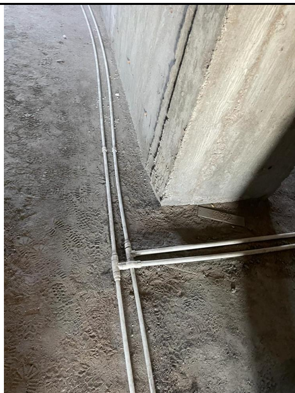
Фото 18 Внутренние помещения объекта оценки
