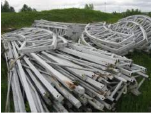
Фото 37. Каркасно-тентовая конструкция 15x19,2 м; АН 15/4 ТУ5282-001- 56293089- 2004
