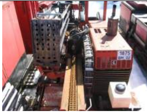
Фото 60. Самоходная буровая установка JT40/20 M1 Ditch Witch; Предприятие-изготовитель CHARLES MASHINE WORKS США; г. н. 02 BM 1875
