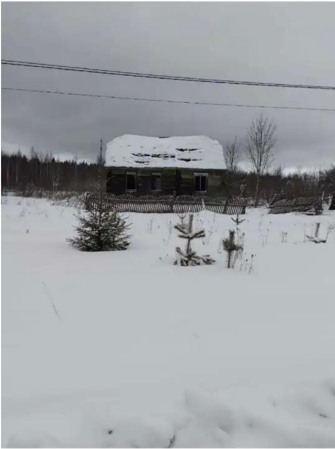
Фото №1. Общий вид дома на участке
