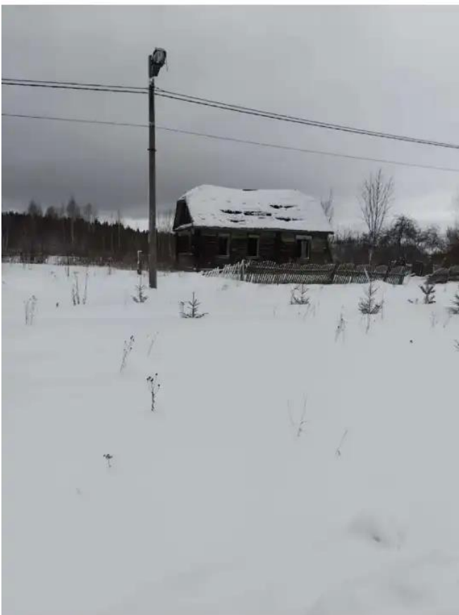
Фото №3. Общий вид дома на участке
