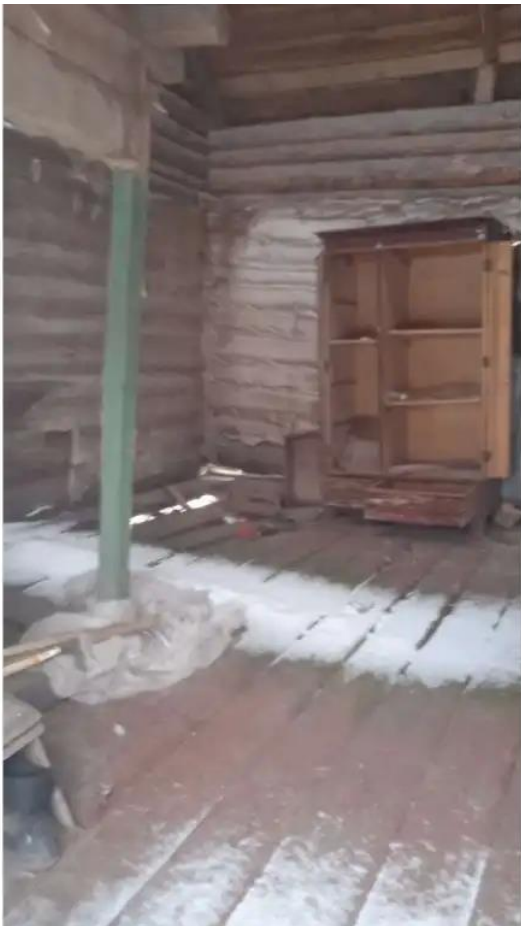
Фото №7. Общий вид дома
