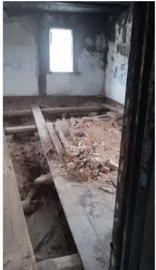
Фото №8. Общий вид дома
