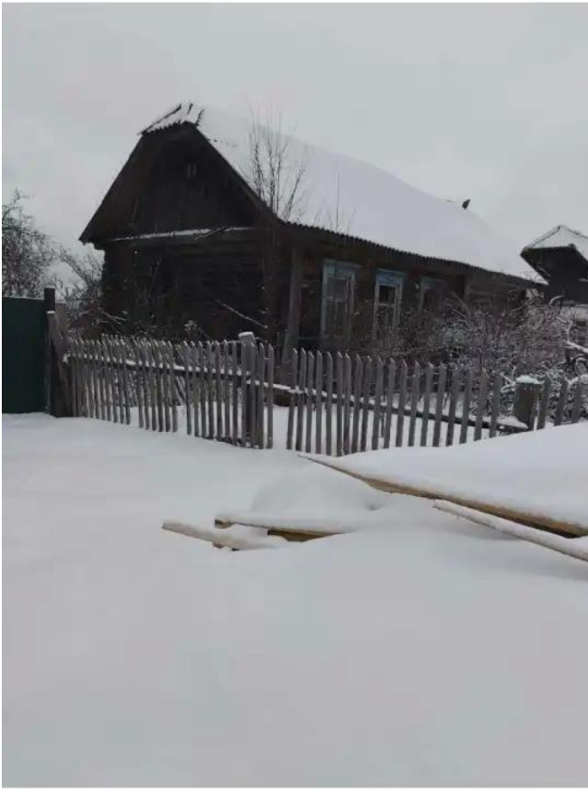
Фото №5. Общий вид дома
