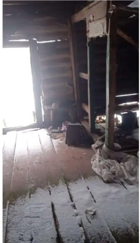
Фото №10. Общий вид дома
