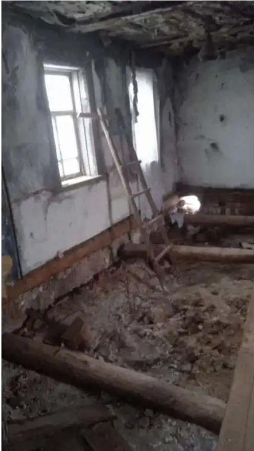
Фото №9. Общий вид дома
