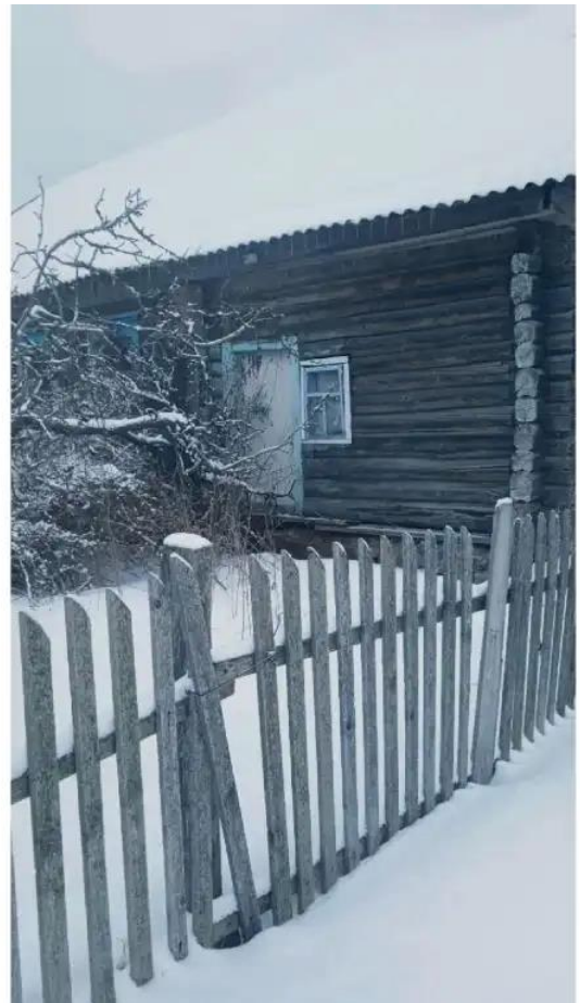
Фото №12. Общий вид дома
