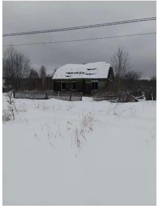
Фото №2. Общий вид дома на участке
