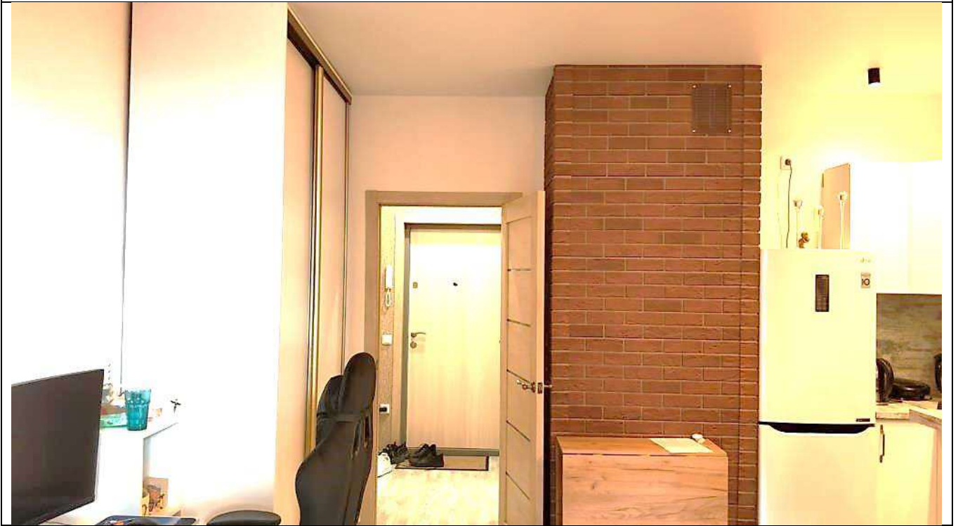
Фото 18. Состояние отделки объекта оценки, комната
