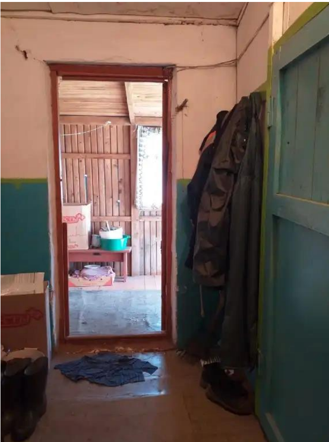
Фото №11. Общий вид дома
