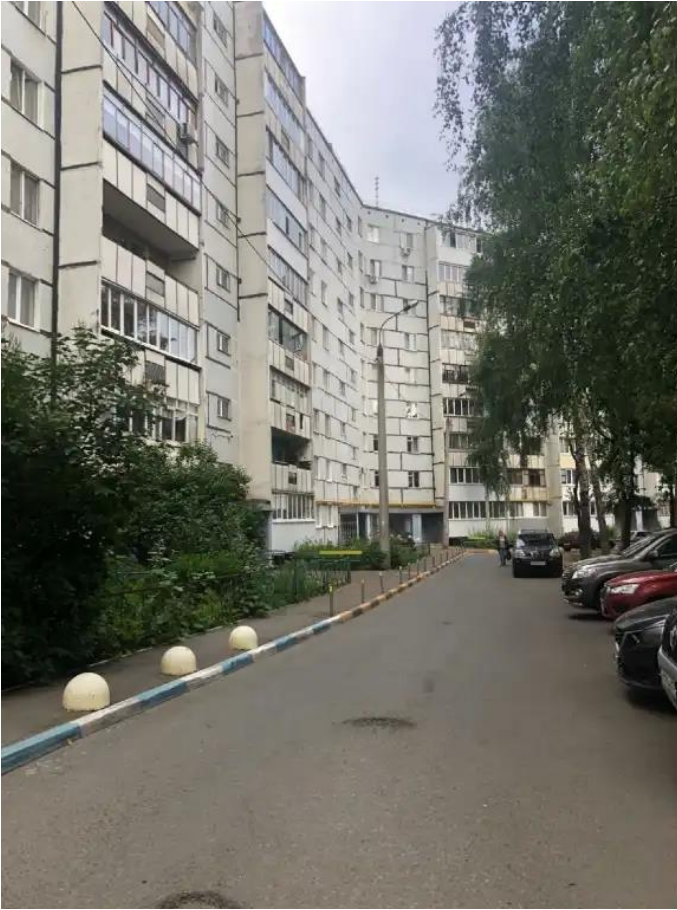
Фото №1. Общий вид дома
