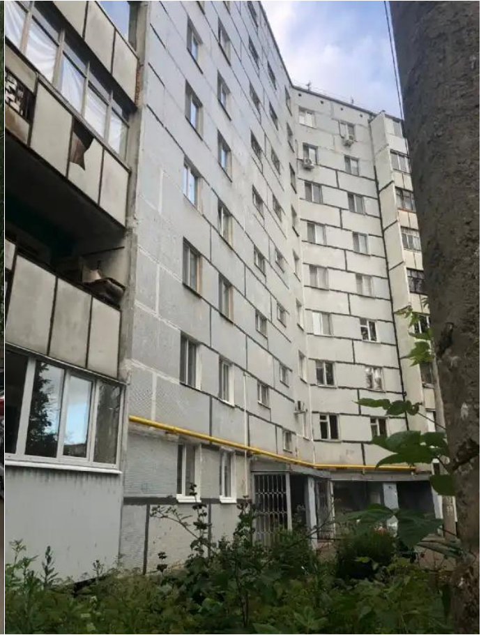
Фото №2. Общий вид дома
