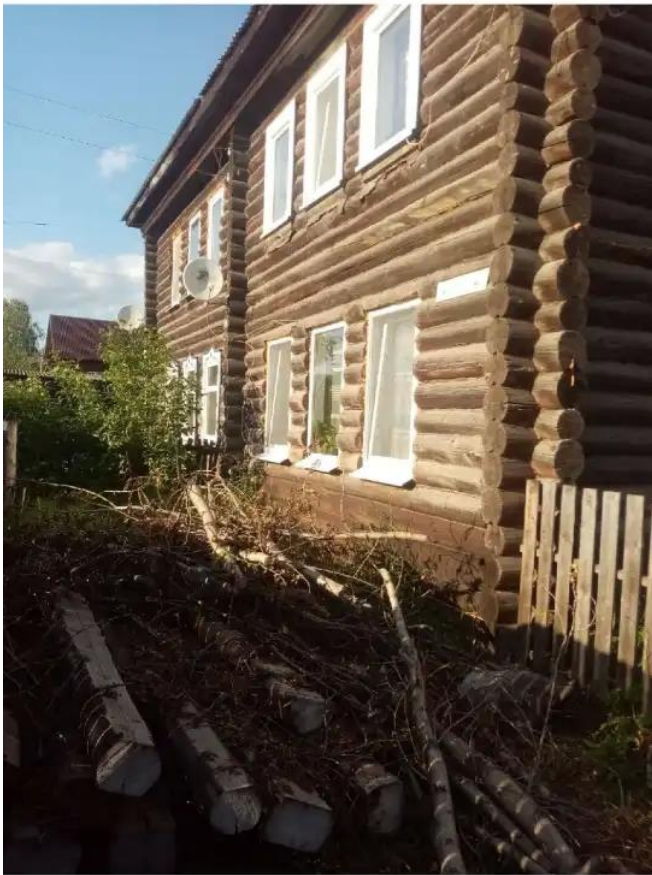
Фото №1. Общий вид дома
