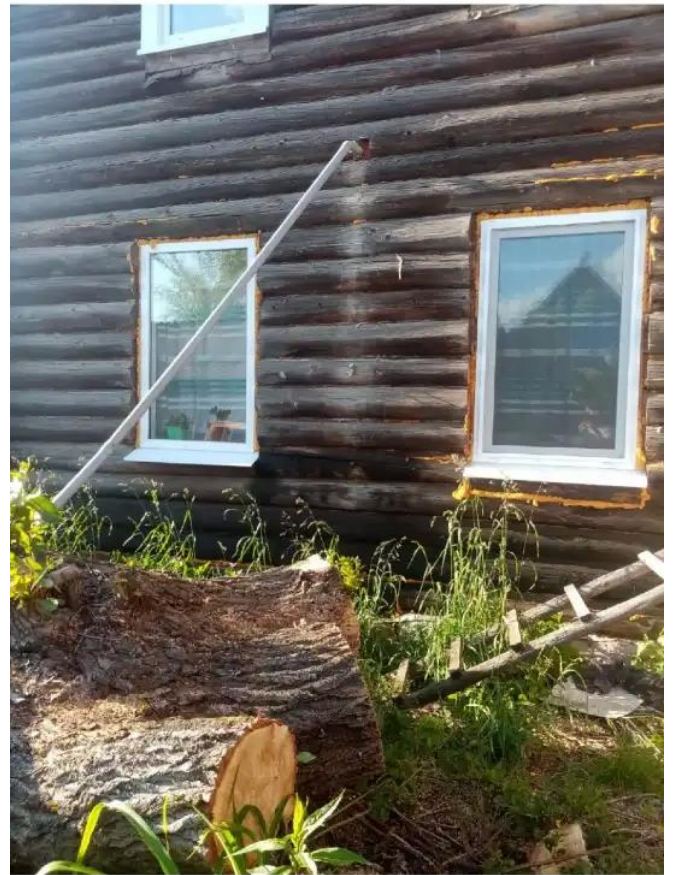
Фото №2. Общий вид дома
