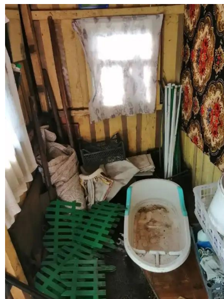
Фото №5. Общий вид дома
