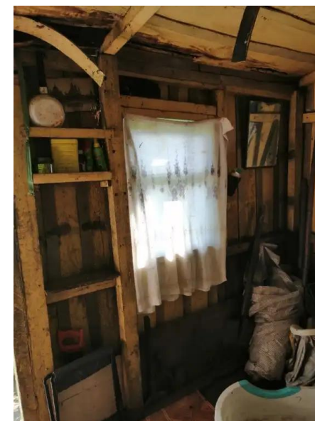
Фото №6. Общий вид дома
