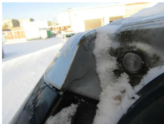
Фото №29. Дефекты эксплуатации
