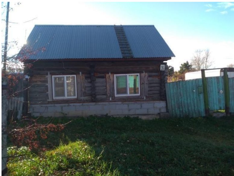
Фото №1. Общий вид дома
