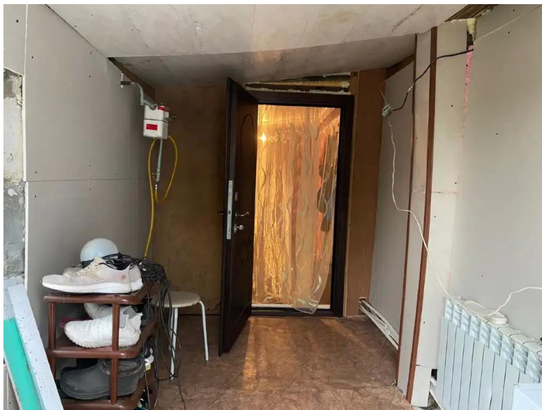
Фото №5. Входная дверь
