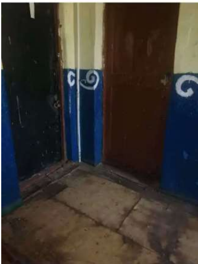
Фото №1. Входная дверь в квартиру
